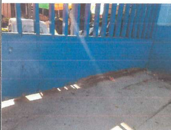
Foto 6: Mantenimiento a Portones
