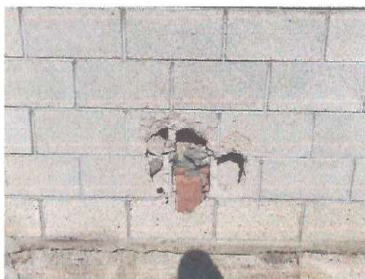
Foto 3: Reparación de Muros de Contención
