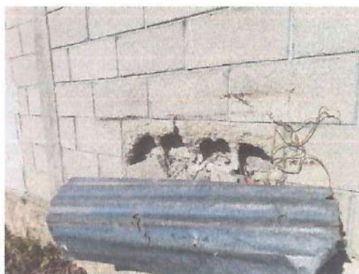
Foto 4: Reparación de Muros de Contención
