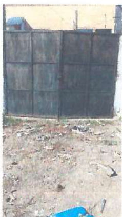
Foto 5: Mantenimiento a Portones
